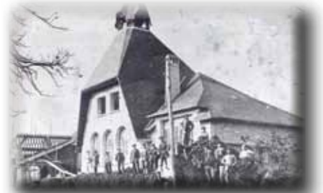
Reconstruction en cours de l'actuelle mairie 1920-1930
