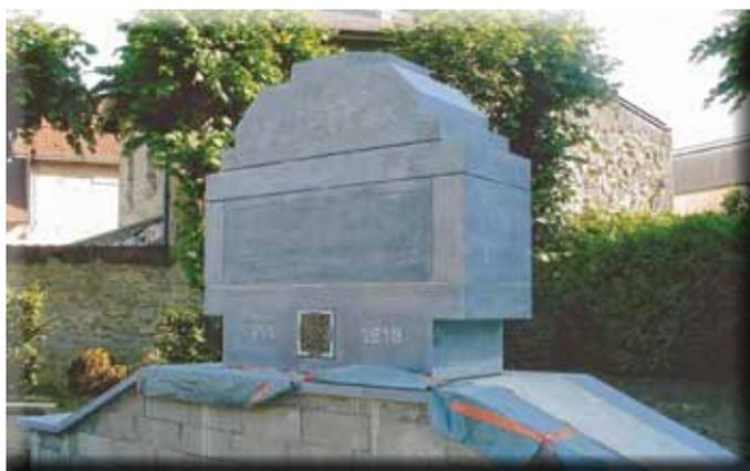
Après avoir refait la fondation en béton armé, les différents blocs ont été minutieusement assemblés, c'était une opération difficile car le plus gros bloc pesait 3 tonnes et devait s'ajuster au millimètre près.
